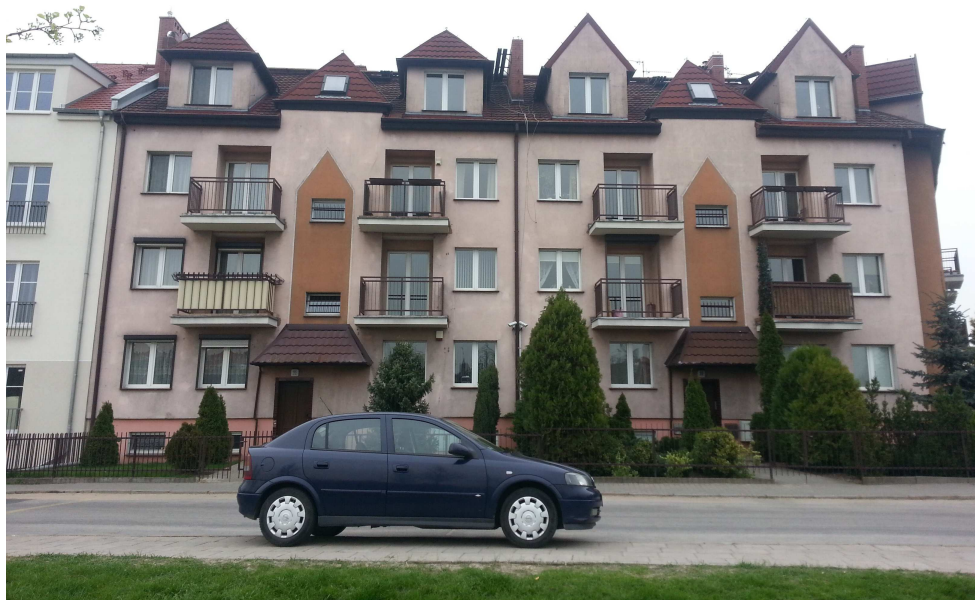
Fot. 1: Elewacja Zachodnia
