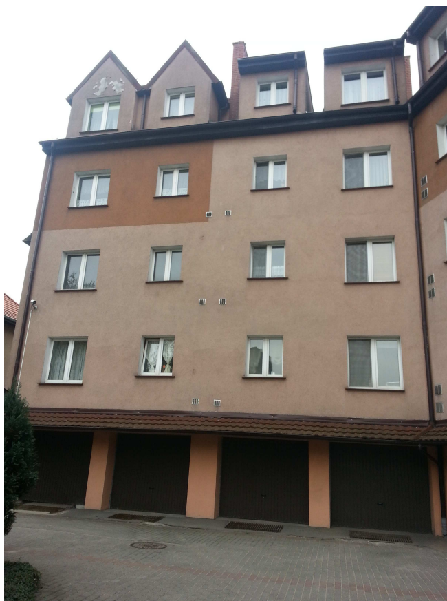
Fot. 4: Elewacja północna
